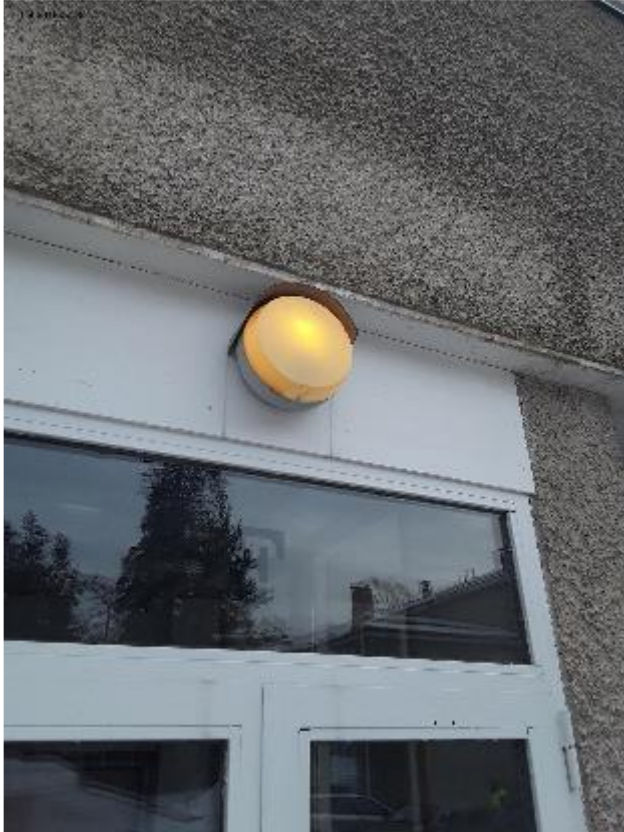
Pahasti kellastuneiden muovikupujen valoteho on huono
