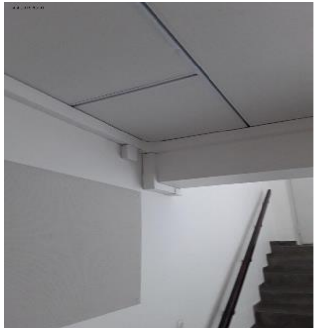
Käytävälle on lisätty muovisia johtokanavia sähkölisästarpeiden vuoksi
