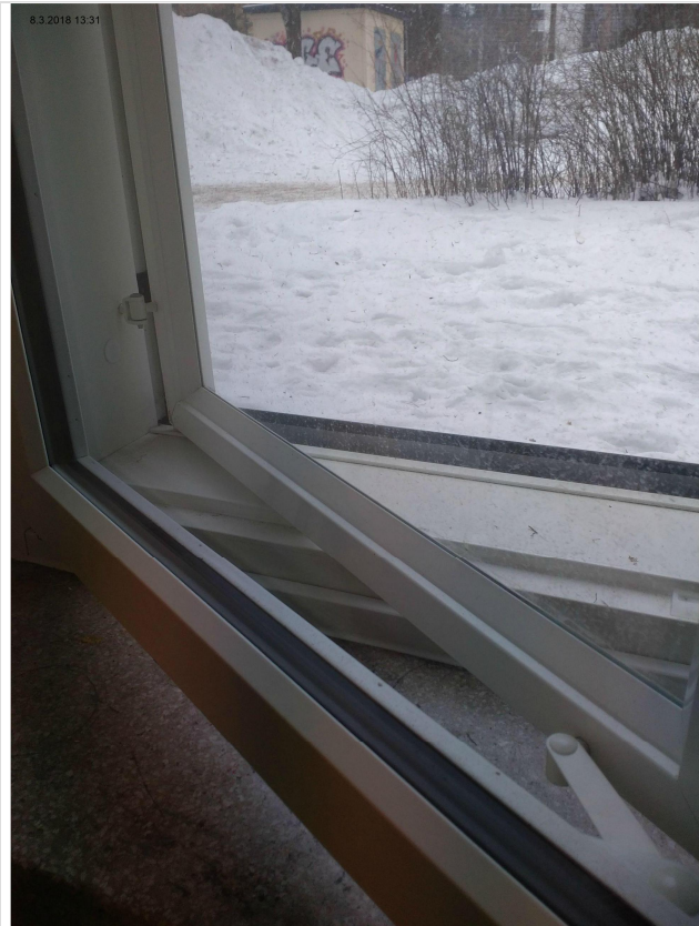
Yleiskuvaa uusituista ikkunoista
