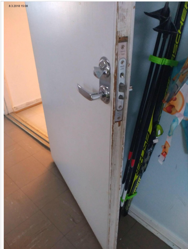
Yleiskuvaa väliovista / luokkahuoneovista
