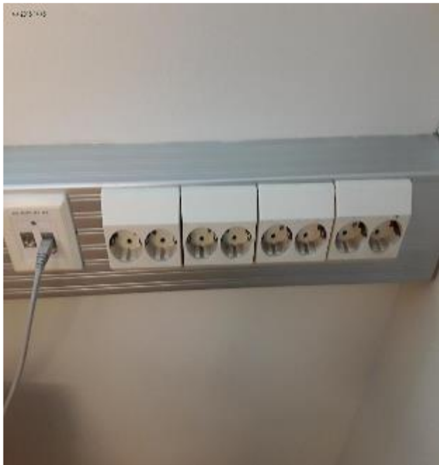
Alumiinisia johtokanavia on käytetty pääsääntöisesti toimisto- ja luokkahuonetoissa
