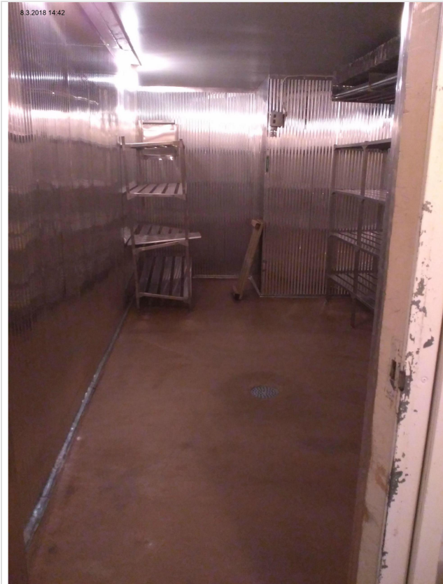
Kylmähuone joka on poistettu käytöstä
