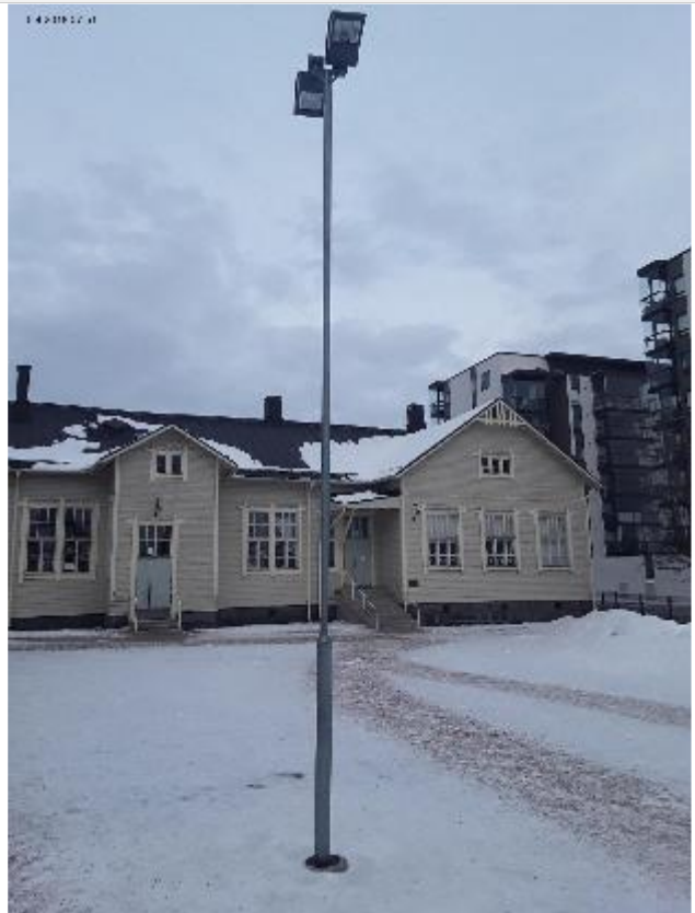
Pylväissä ei havaittu ulkoisia vikoja
