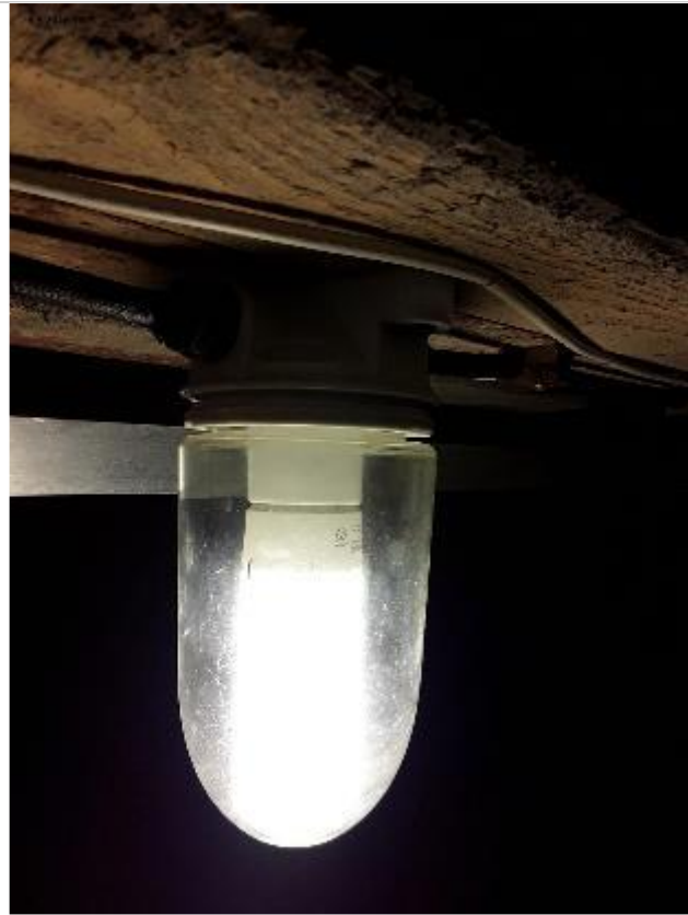
Alkuperäisiä valaisimia havaittiin ullakkotiloissa, ylimmässä kerroksessa
