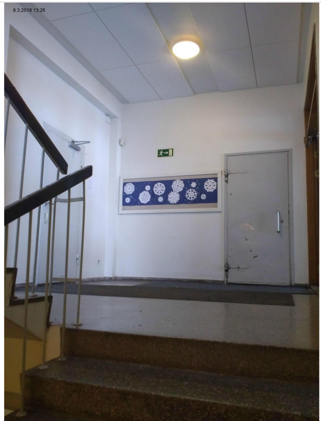
Yleiskuvaa käytävä- ja porrashuonetoista
