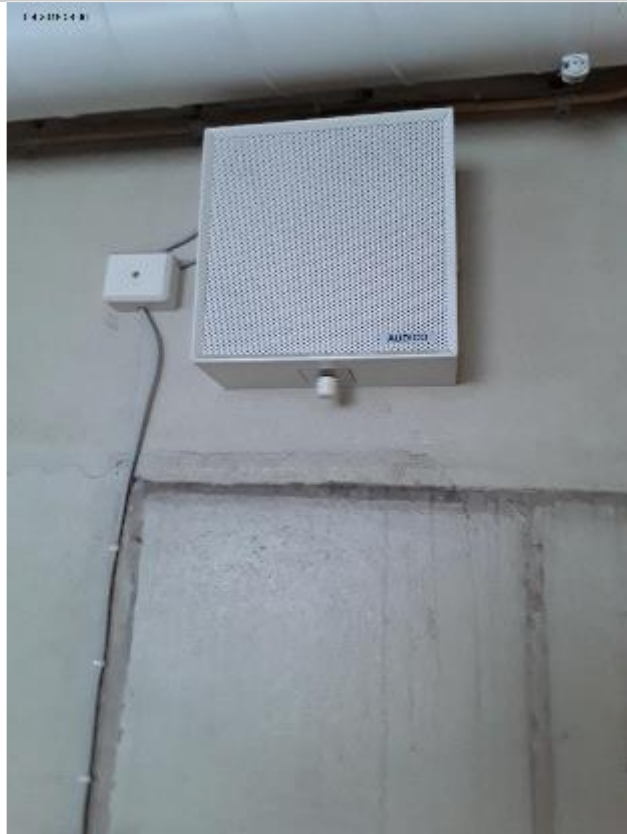
Kuulutusjärjestelmän kaiuttimet ovat vaihdettu v.2001
