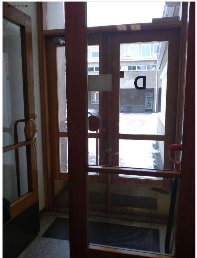
Yleiskuvaa kiinteistön ulko-ovista
