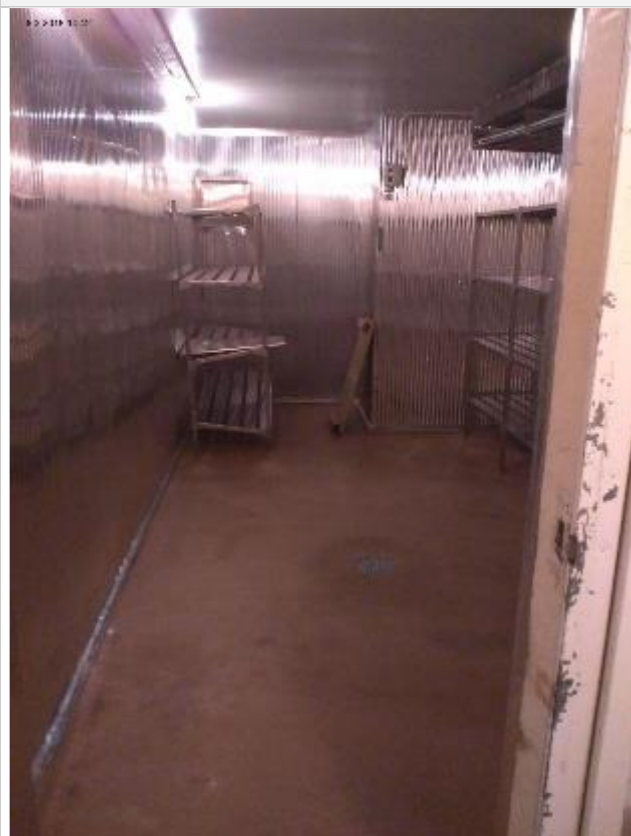
Kylmähuone joka on poistettu käytöstä.
