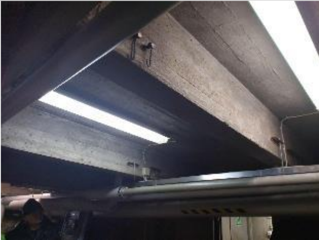
Yleiskuva kiinteistön runkorakenteista, palkit
