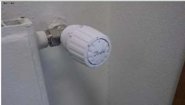
Yleiskuva termostaattisesta patteriventtiilistä
