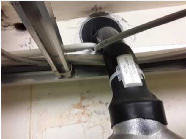
Pääkeskukselta lähtevä RK6:n syöttö on nelijohdinjärjestelmäinen
