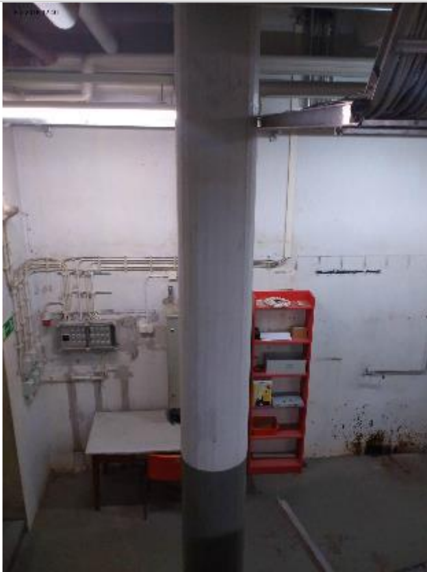
Yleiskuva kiinteistön runkorakenteesta, pilarit
