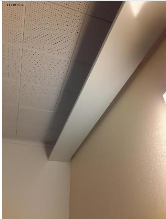
Tikashyllyt ja levyhylyt ovat silmämääräisen tarkastelun perusteella hyvässä kunnossa
